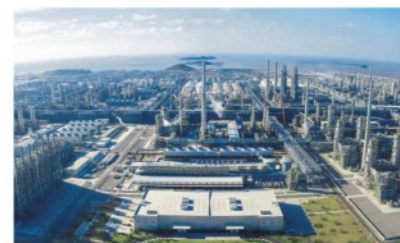
浙江石油化工有限公司 4000万吨/年炼化一体化项目
