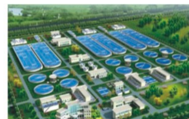
首创爱华(天津)市政环境工程有限公司 爱华枣庄高新区污水处理厂(日处理污水6万立方米) 安徽颍上污水处理厂(日处理污水2万立方米) 梁山县污水处理厂(日处理污水5万立方米)
