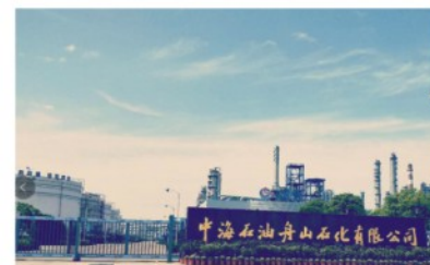
中海石油舟山石化有限公司 建设运行五部烟气脱硫项目
