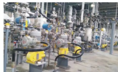
无锡洪汇新材料科技股份有限公司 6万吨乳液项目
