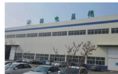
青岛国电蓝德环境工程有限公司 多款计量泵及成套化学加药装置在国电蓝德 项目中成功使用。
