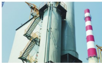
杭州杭联热电
