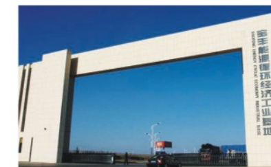
宁夏宝丰能源集团股份有限公司 60万吨/年煤制烯烃项目及220万吨/年甲醇工程
